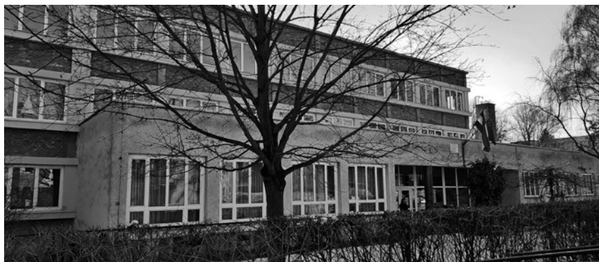
Az iskola épülete
